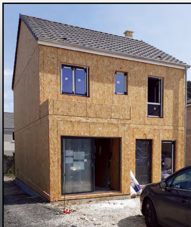
Rapidité de construction
