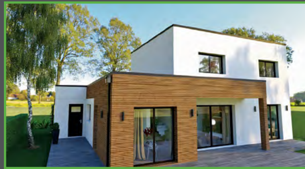
Rapidité de construction
