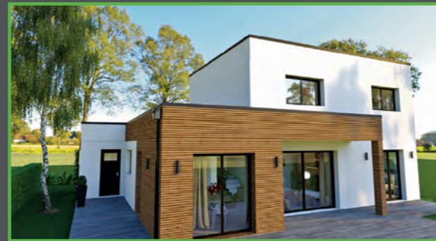
Rapidité de construction
