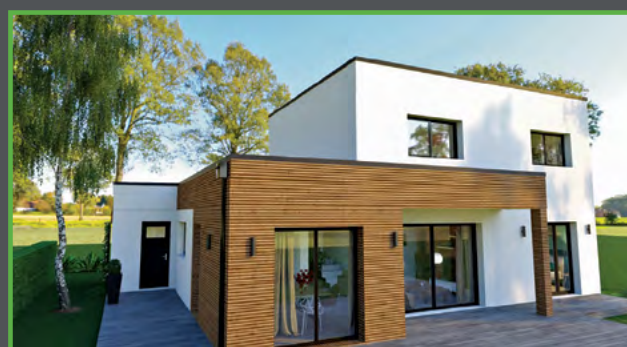
Rapidité de construction
