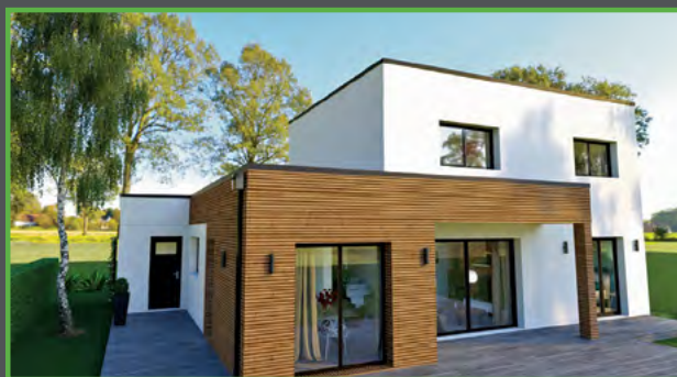
Rapidité de construction
